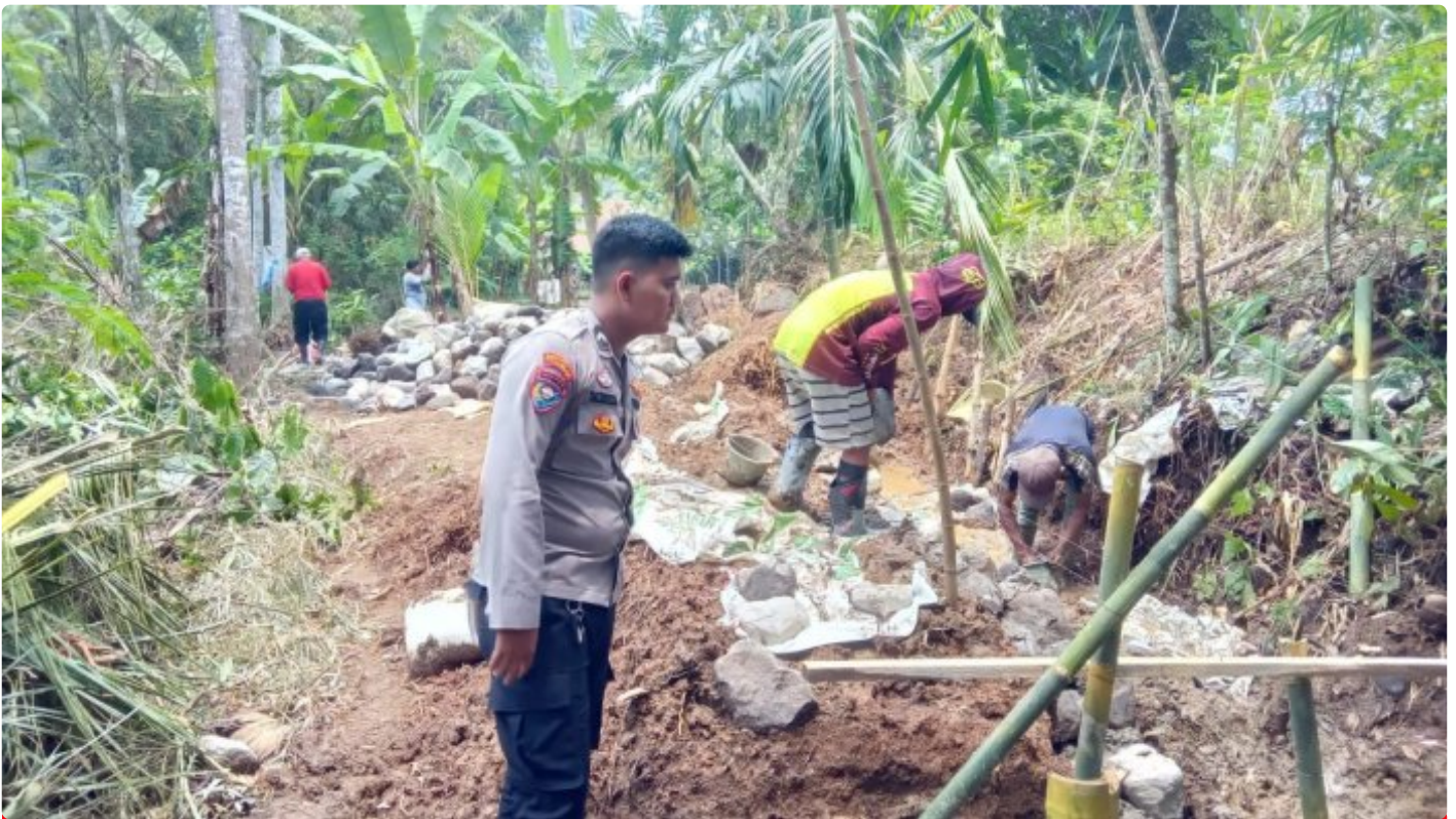
Bhabinkamtibmas Cijengkol Memantau Pembangunan Irigasi di Wilayah Desa
